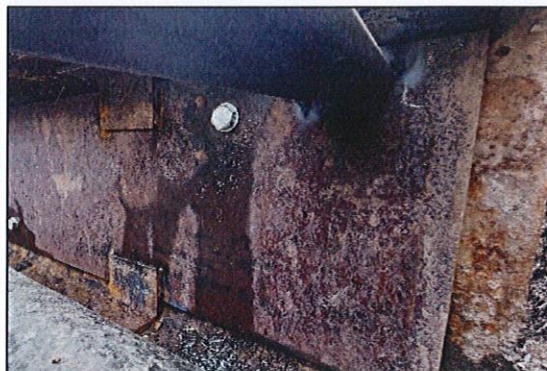
Illustration des poutrelles du tablier du pont des Sanières dégradées
