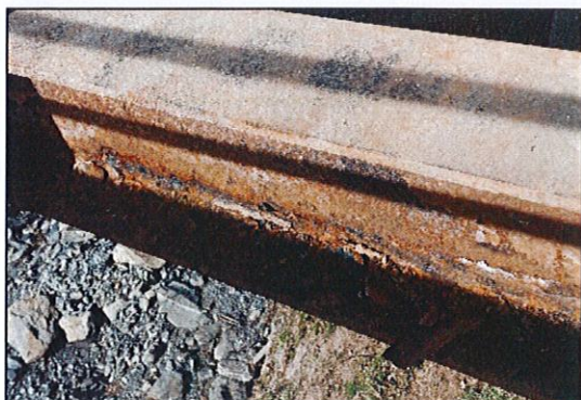
Illustration des poutrelles du tablier du pont des Sanières dégradées
