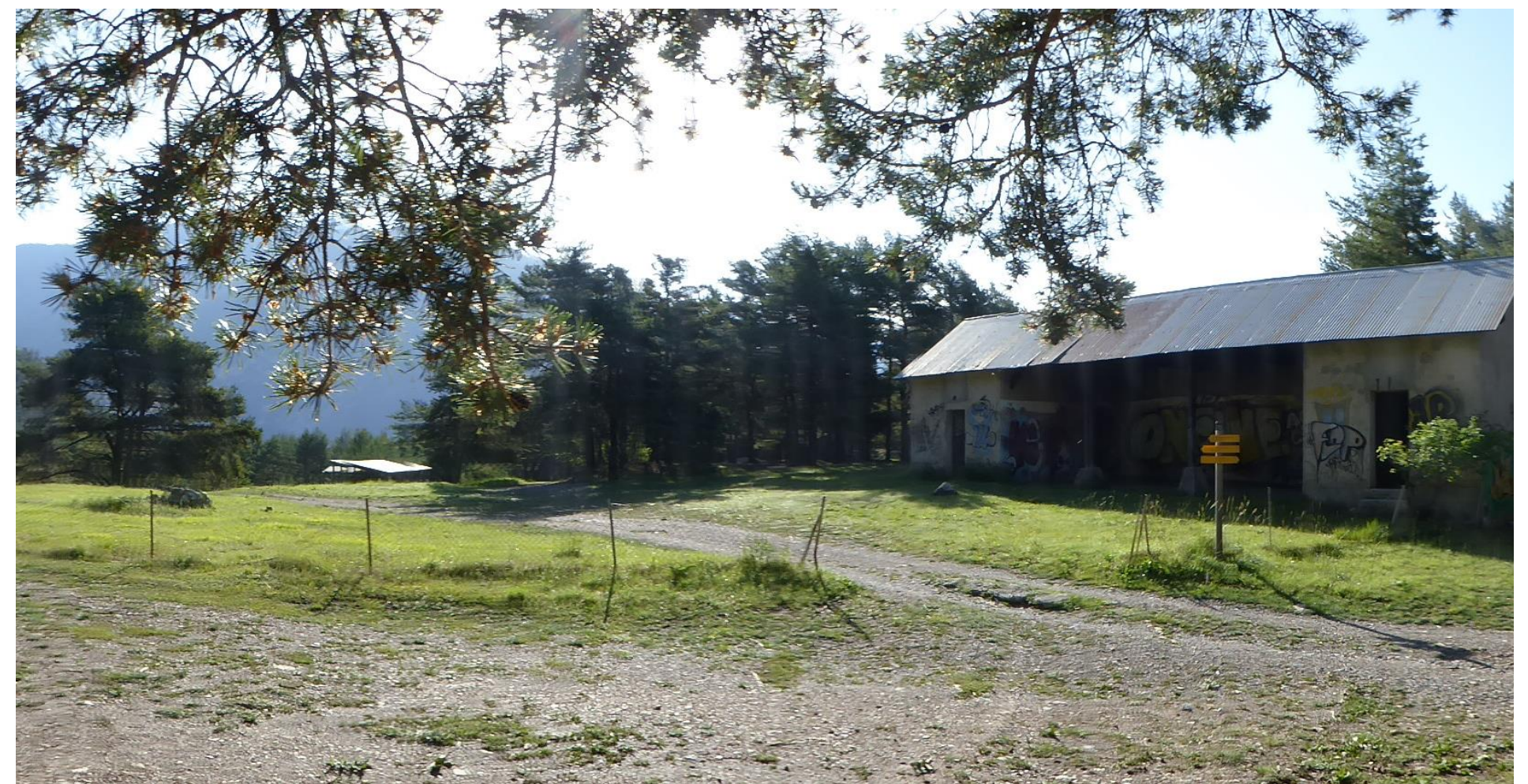
Bâtiment existant et conservé
