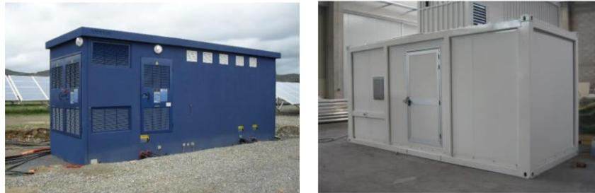
Photographie 4. Exemples d'onduleurs et transformateur installés dans des postes béton et containers
