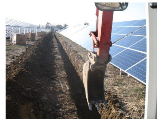
Les câbles électriques nécessaires au transport de l'énergie vers le point de livraison au réseau seront installés le long des structures métalliques, sur chemins de câble ou en souterrain. Les réseaux de communication et de mise à la terre seront enterrés ou sur chemins de câble.
