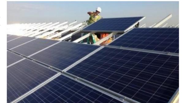
Photographie 6. Exemple de mise en place des panneaux sur les structures
