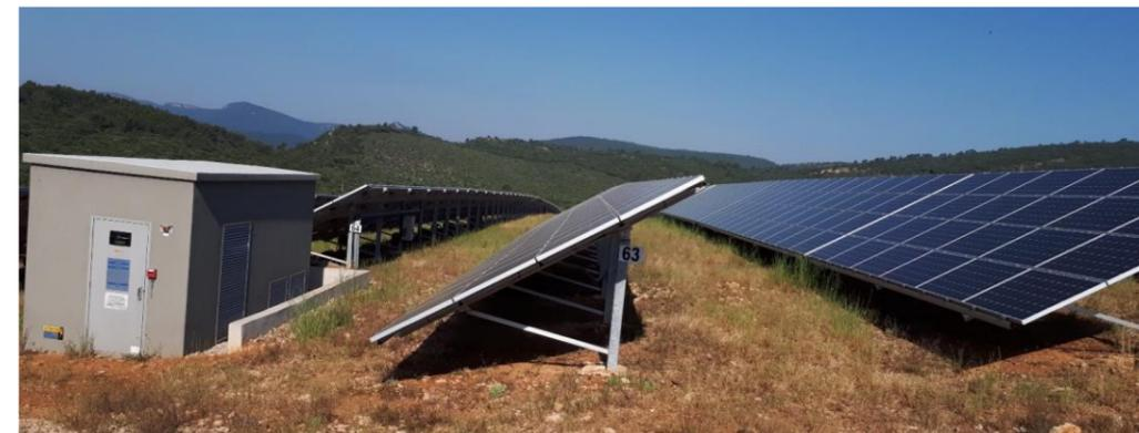
Photographie 3. Exemple de structure fixe
