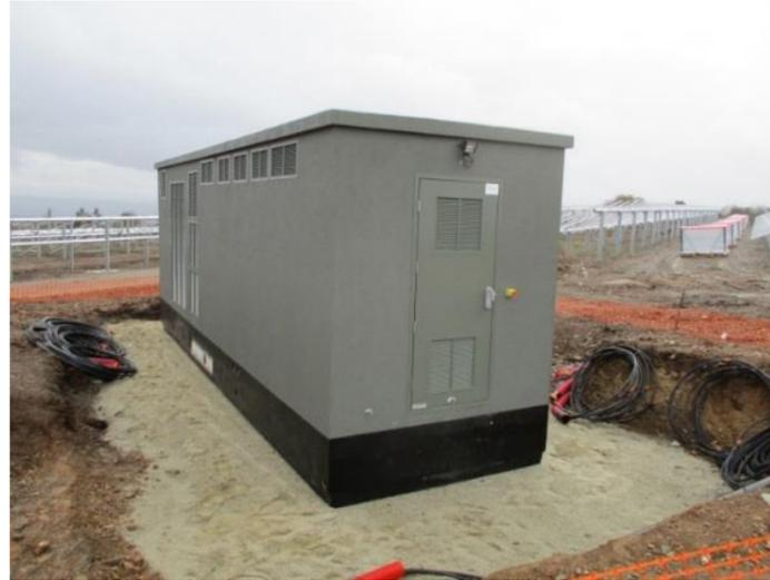
Photographie 8. Installation d'un poste électrique
