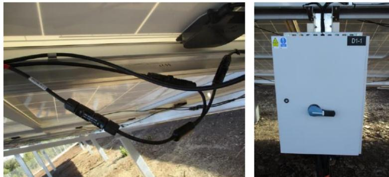
Photographie 5. Exemple de câble électrique et de boîte de raccordement
